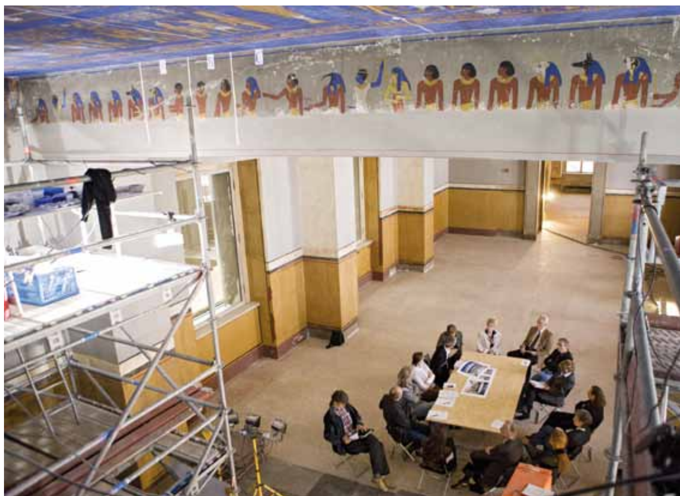
Les plans de réhabilitation du Nouveau musée sont débattus régulièrement sur place lors de rencontres avec les utilisateurs
