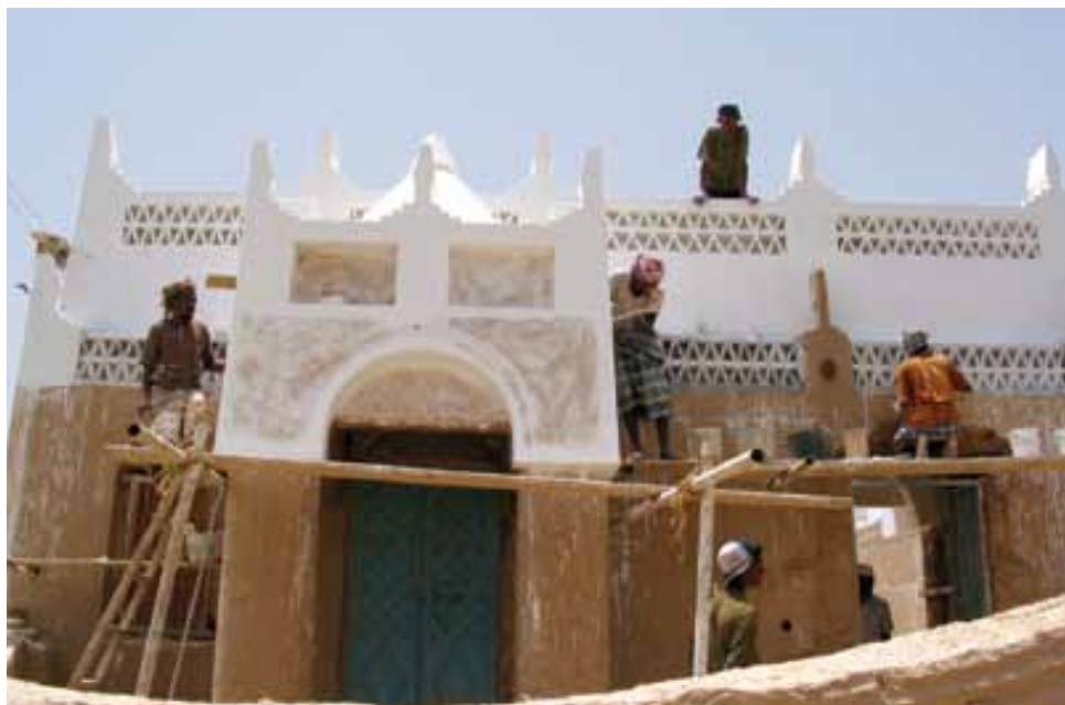
Des experts de la GIZ ont accompagné les travaux de réhabilitation de la mosquée Ma'ruf à Shibam
