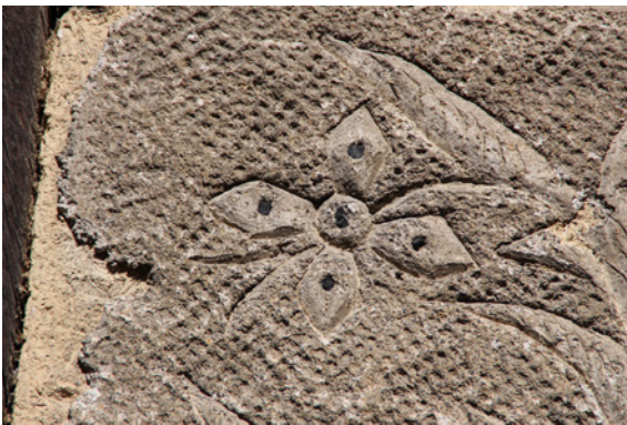
Kratzputztechnik ausgeführt von Weißbindermeister Damm.
